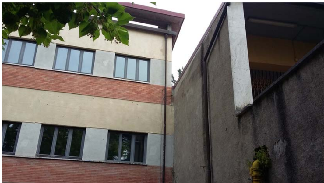
A destra porzione oggetto di demolizione Fronte Ingresso
