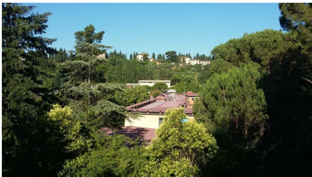
Vista da Via Carlo Pisacane – lato sinistro a salire In basso la copertura della porzione da demolire
