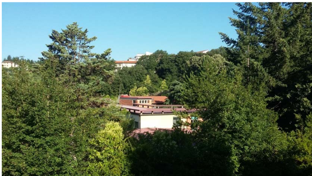
Vista da Via Carlo Pisacane – lato sinistro a salire In basso la copertura della porzione da demolire
