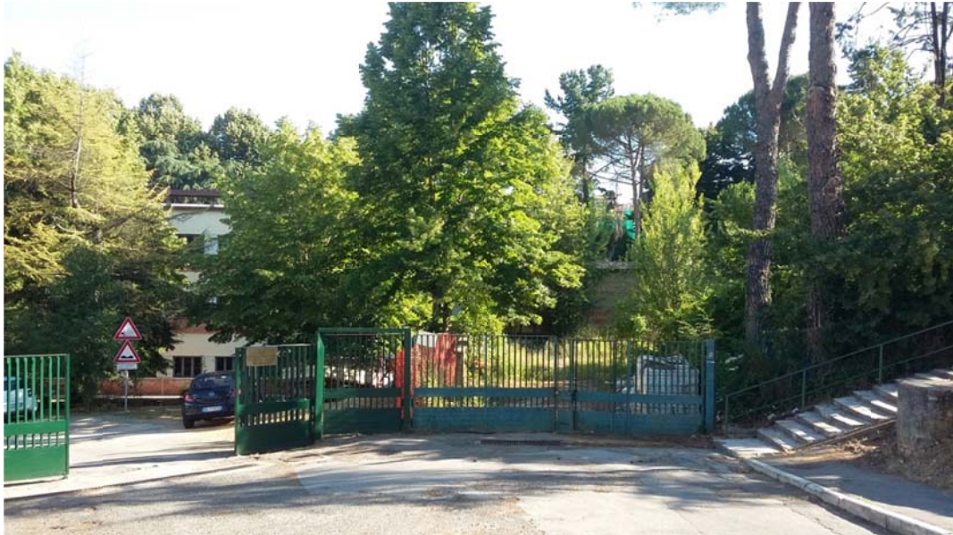
Vista ingresso – Sinistra Istituto G. Marconi - Destra ingresso porzione interessata al progetto Sullo sfondo a destra porzione da demolire
