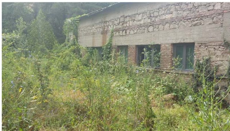
Edificio recentemente demolito - Retro edificio
